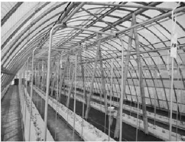
バンブーグリーンハウスの内部イメージ。放置竹林で間伐された孟宗竹が構造物として活用されている。
